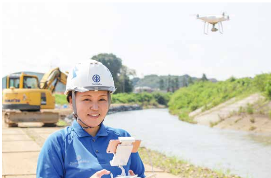
現場でドローンもあつかっています
